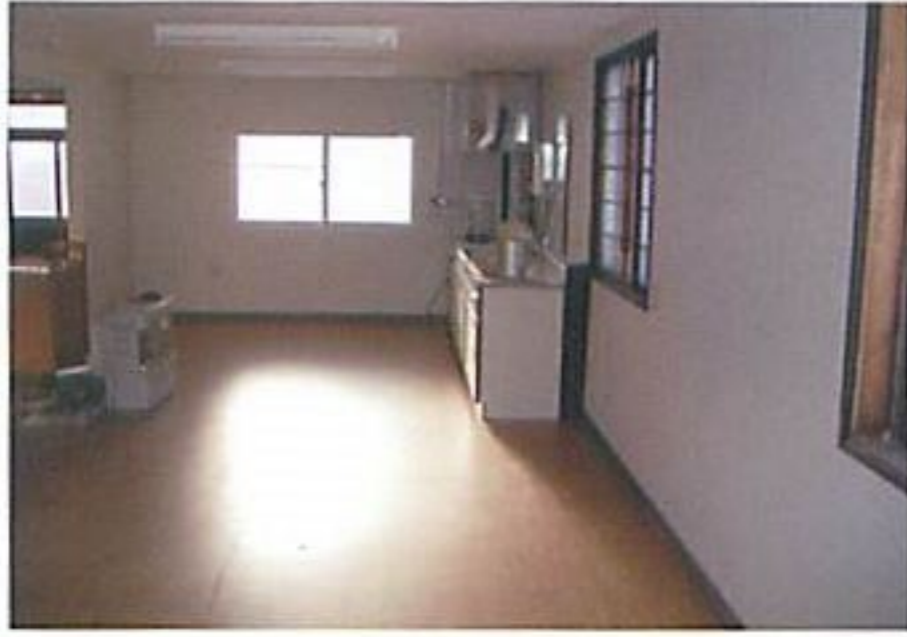
▲改修されたためぐみ寮
